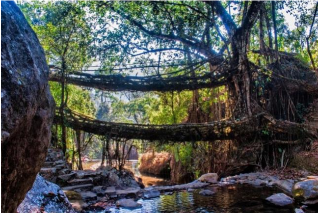
Cherrapunji 'levende' brug gemaakt van de wortels van de rubberbomen die gewoon doorgroeien zodat de brug steeds steviger en groter wordt
